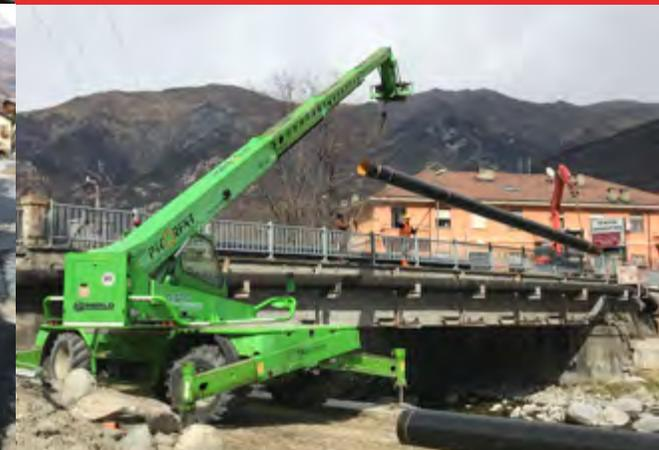
**Descrizione opera:** Comune di Pomaretto, Perosa Argentina, Usseaux e Pragelato. Collettamento fognario e depurazione delle acque reflue delle Valli Chisone e Germanasca – Tratto Usseaux - Pragelato e nodo Perosa Argentina. Fornitura, posa di circa 5000 m di tubazione fognaria DN 500 di diversa tipologia quali ghisa, PVC ed acciaio per la costruzione del collettore fognario di valle.
