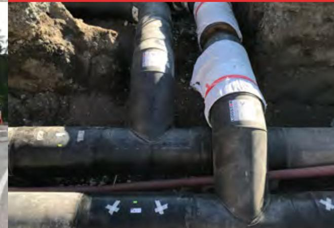
**Descrizione opera:** Scavo, posa e saldatura condotte di teleriscaldamento comprese tutte le opere accessorie quali muffolatura, posa materassini di compensazione, realizzazione sottostazioni di compensazione, prove sulla continuità di protezione ed isolamento e prove di tenuta della condotta – esclusione della fornitura dei materiali
