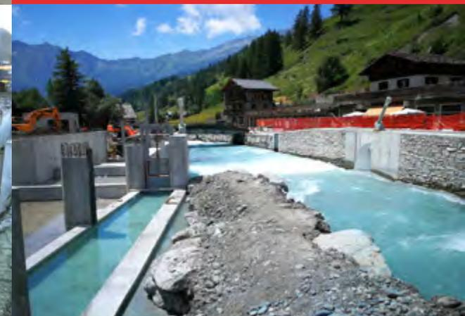
**Descrizione opera:** Realizzazione nuovo impianto idroelettrico Amponey sul torrente Evancon nel comune di Ayas (AO) in località Champoluc costituito da: - opera di presa e vasca di carico in c.a.; - condotta forzata DN1800 sp.10,00 mm bicchierata per una lunghezza complessiva di 650 ml compreso il subalveo di attraversamento del torrente Evancon; - fabbricato centrale in c.a.; - canale di scarico in c.a.
