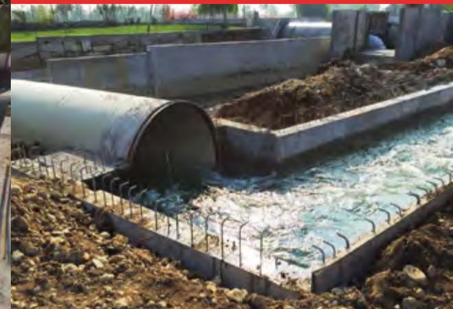
**Descrizione opera:** Realizzazione nuovo impianto idroelettrico nel Comune di Caluso denominato «Caluso Basso». Scavo, posa, saldatura tubazione in acciaio bicchierata DN2500 e DN2000 (circa 500 metri) e successivo rinterro e compattazione del terreno.
