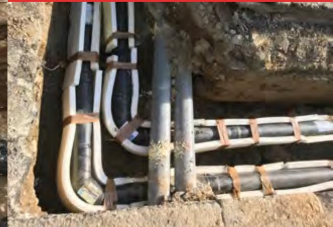
**Descrizione opera:** Realizzazione rete teleriscaldamento nel concentrico di Luserna San Giovanni (TO). 2500 m di scavo a sezione obbligata per la posa e saldatura delle tubazioni preisololate del teleriscaldamento con diametri dal 250 al 25; compresa l'esecuzione degli allacci alle singole utenze.
